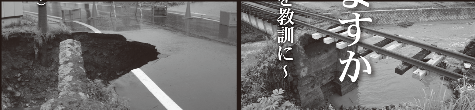
【写真】市内豪雨被害の爪あと(上)平成25年7月、冠水した南陽警察署前県道(右下)平成26年7月、濁流で橋梁が削られ、宙吊り状態になったフラワー長井線の線路(左下)平成26年7月、路肩が崩落した中川地区の県道原中川停車場線
