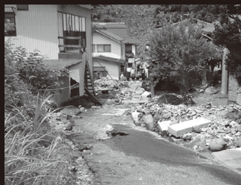
▲平成25年7月、土砂崩れが発生した萩地区。山間部は、雨が収まってからも土砂崩れに警戒が必要
