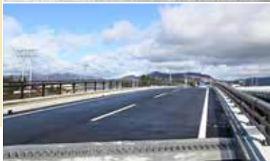
▲開通した大橋
