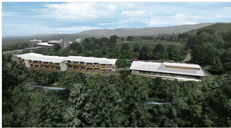
▲隈研吾さんが設計する宿泊施設のイメージ図（現段階の計画であり、今後変更となる可能性があります） 画像提供＝株式会社四季南陽
