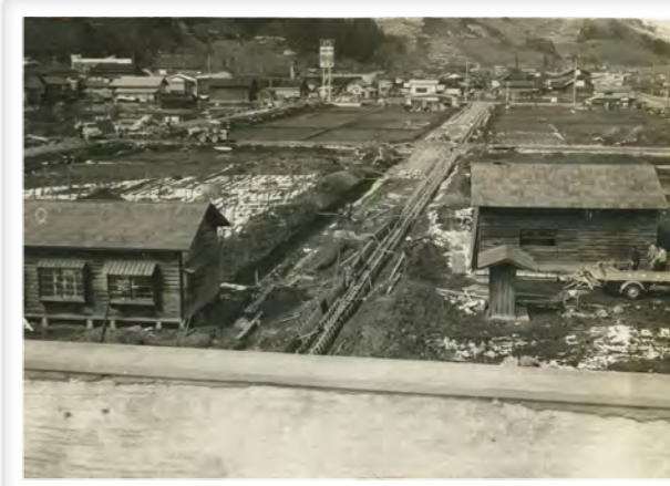
▲竣工間近のあずま湯屋上からの風景(昭和41年撮影)。
