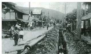
▲水道管理設工事 (赤湯地区表町・1934)
