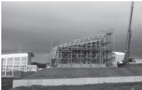
建設中の赤湯学童保育施設
