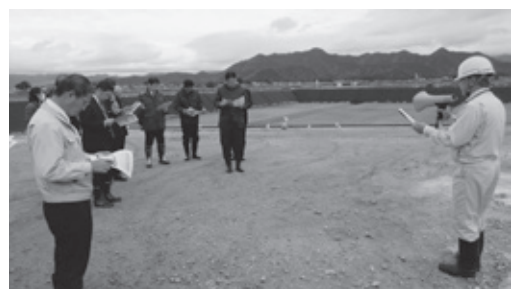
浅川最終処分場建設現場
