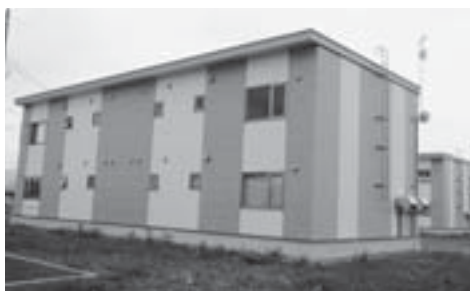
幌加内町（移住者用アパート）
