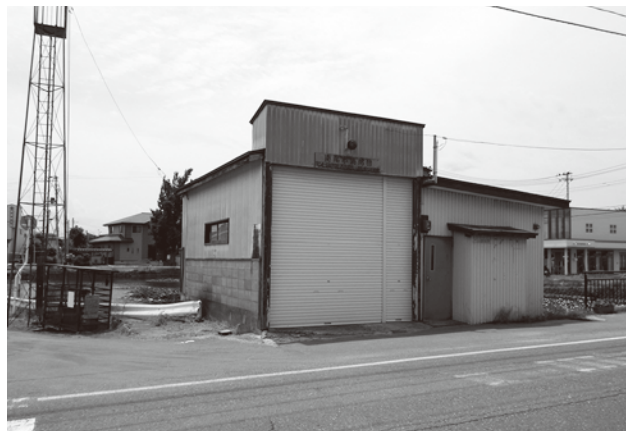
移設予定の花見町堤わきポンプ庫
