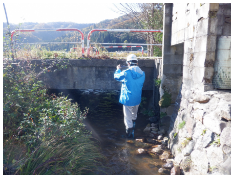
直営点検状況
