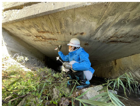
直営補修状況（防錆スプレー）
