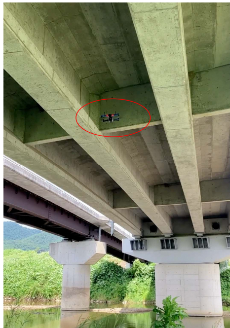
上野中央線 新生橋（昭和60年架設）ドローン点検状況
