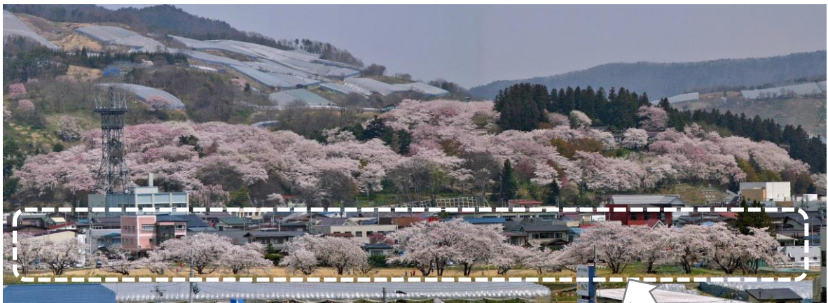
写真9 堤防の桜の様子
